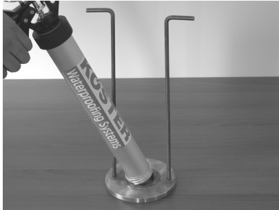
1. Sosis tabancasının ucunu sökerek adaptöre monte ediniz.
